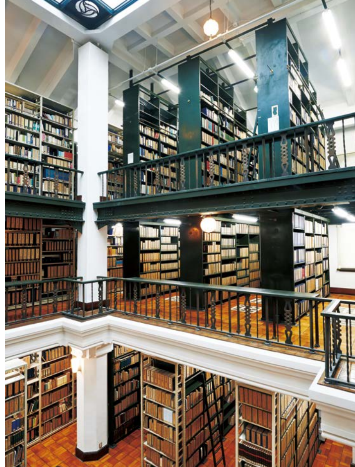
鉄骨三層構造の書庫
