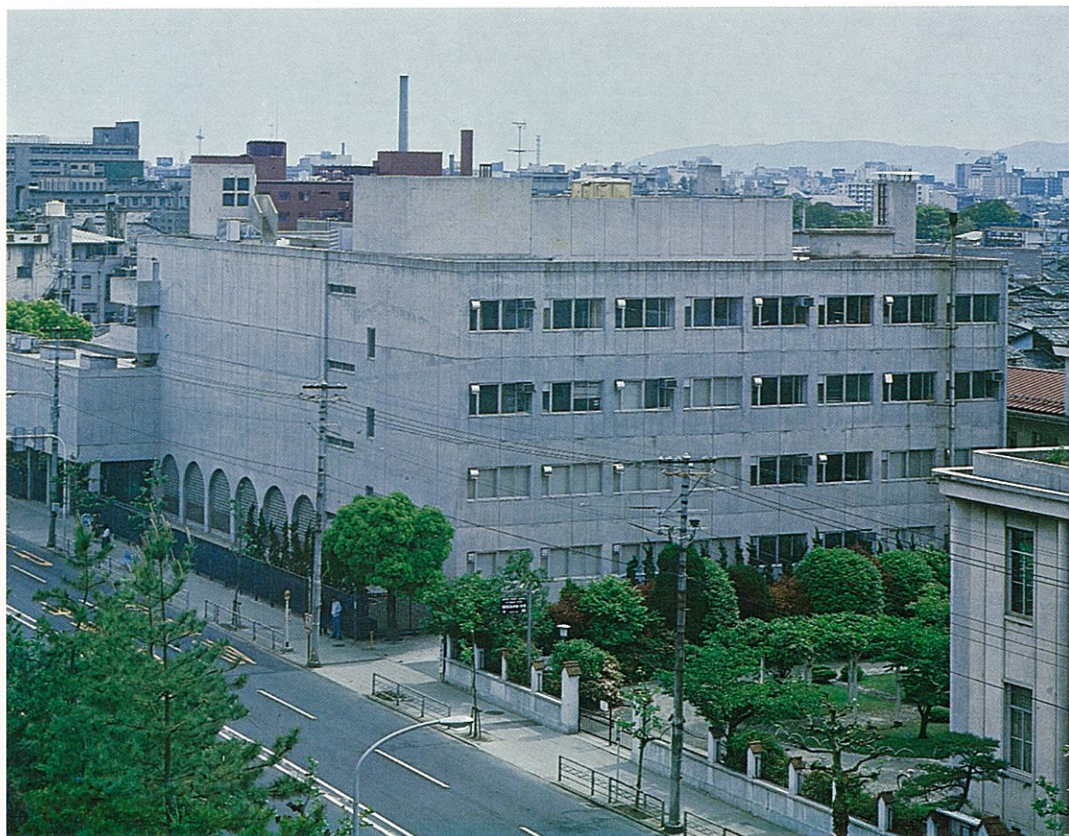
1975年竣工の東一条の所屋
