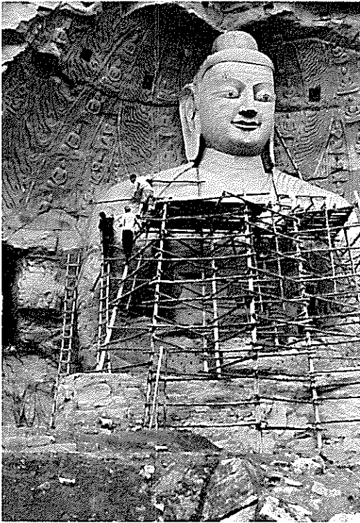
雲岡第20洞大仏に組まれた足場
