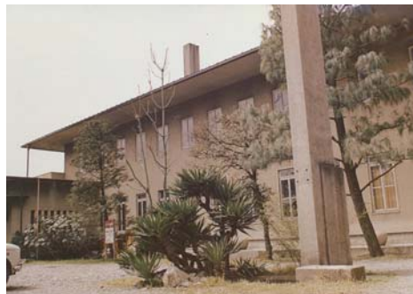
旧分館(東一条)の建物
